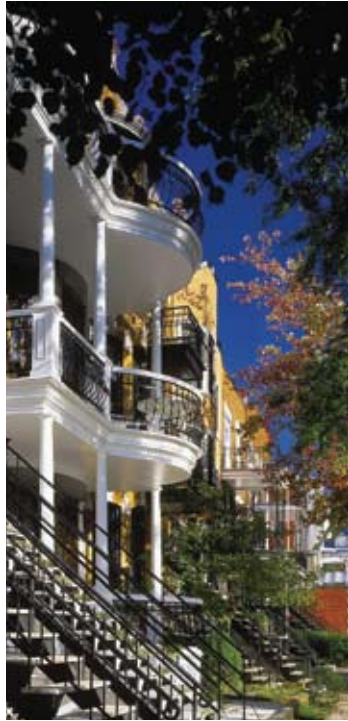
Escaliers extérieurs, Tour de la Presse, 1900
